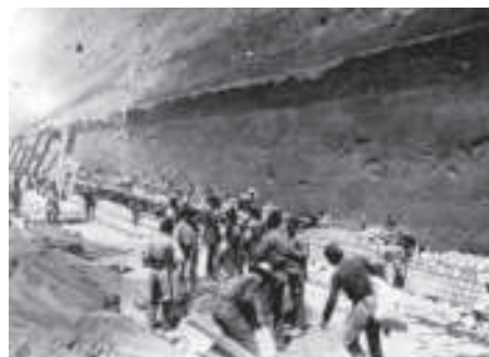
Изградба на Коринтскиот канал
